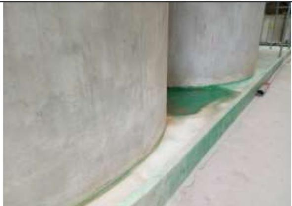
储罐地面防腐防渗及围堰
